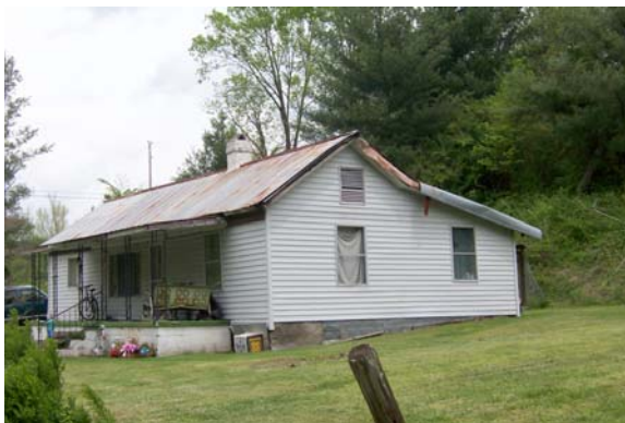
Another tenant house
